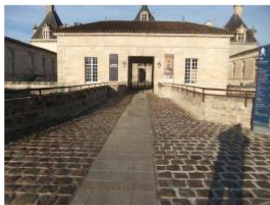
Bande de circulation PMR intégré aux pavages du pont de l'entrée
