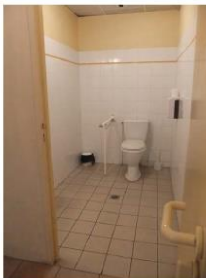
Sanitaire PMR avec espace de manoeuvre, barre d'appui et lavabo réglementaire dans l'angle à gauche en entrant
