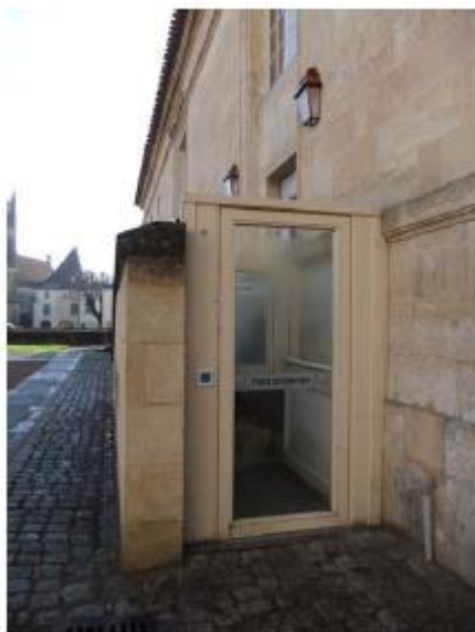
Monte-personne aménagé sur la cour d'honneur le long de l'aile Sud donnant accès à l'ensemble du rez-de-chaussée visité
