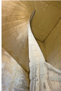
Escalera de caracol suspendida.
